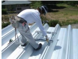
② 設置箇所は、親綱システム用支柱の使用基準(次ページ表1及び図1)に従って計測し位置決めをしてください。
