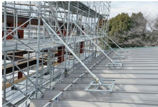
ハゼ金具で挟み込んで固定し、屋根面への負荷が少なく、取付けは、インパクトレンチで簡単に設置できます。丸ハゼ、角ハゼ、重ね式、様々なタイプの折板屋根に取付けることができます。正面用と側面用の2タイプあります。屋根方向、用途に合わせてご利用いただけます。
