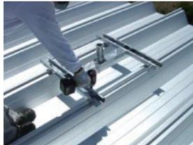
④ ハゼ金具のナットをインパクトレンチで締め込み固定してください。(ハゼ金具4ヶ所)
