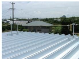
⑧ 親綱を取付け、緊張器を用いて、概ね水平になるように緊張して完成です。
