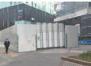
土木(開口部養生) 外観
