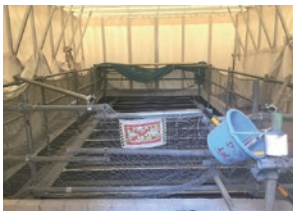
土木(開口部養生) 内観
