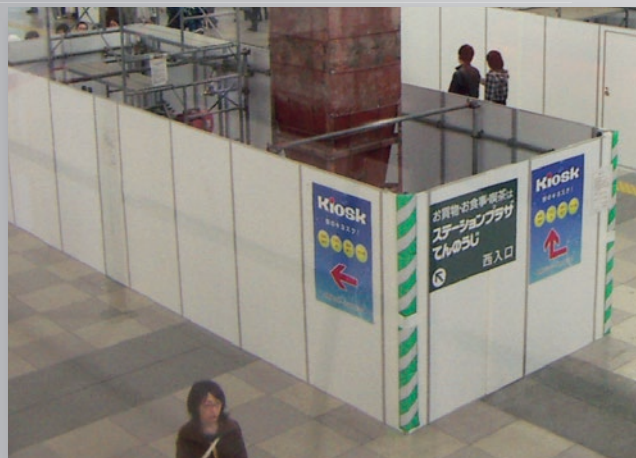
駅舎構内工事物件 利用者 防音対策と軽量・美観性(H:2000mm仕様)
