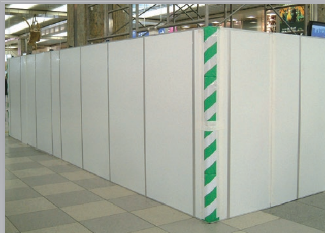
駅舎構内工事物件 利用者 防音対策と軽量・美観性(H:2000mm仕様)
