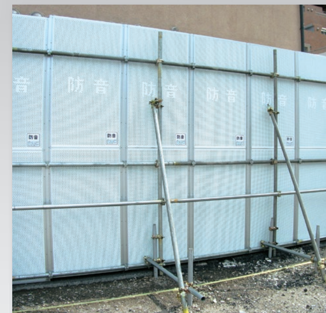
裏面、吸音構造 デザインパンチングで防音文字を表現しました。
