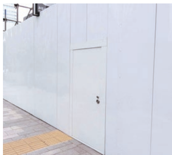
ドアパネル設置写真 (表側)
