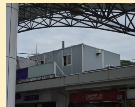
駅舎屋上：現場詰所
