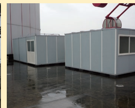
商業施設屋上：現場事務所&詰所
