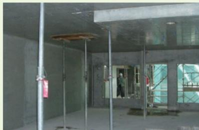
一般支保工解体直後（打設後約4日目）
