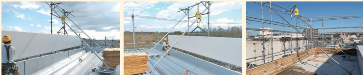
ウインチの架台を支持サポートして荷揚げ、荷下ろしを安全にできます。
