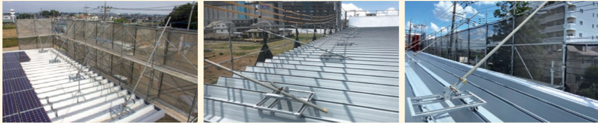
足場の上端部を支持できるので、支持不足のぐらつきを押さえ、安心して作業が行えます。
