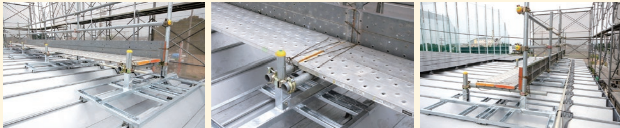
歩み板、手すりが設置できるので屋根上での作業・移動が安定します。
