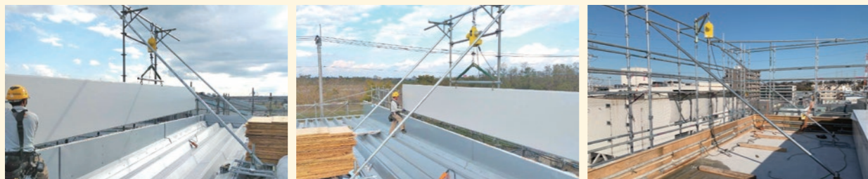
ウインチの架台を支持サポートして荷揚げ、荷下ろしを安全にできます。
