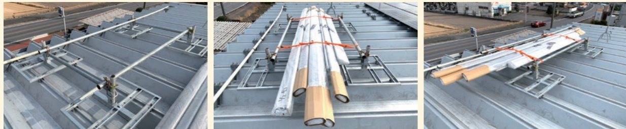
荷受け架台を屋根上に設置できるので、部材等を安定させたまま、養生・保管が行えます。
