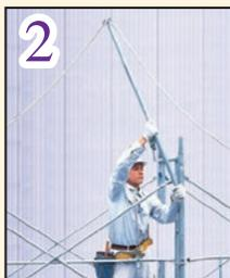
親綱を支柱上部のオープンアイに掛け建枠に取付け
