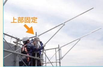
④ ブラケットと縦地支柱の垂直調整をして下部クランプを固定します。
