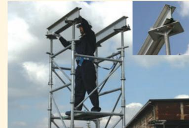
⑪ ヘッドフレームにブレースA11(水平ブレース)を取付けます。
