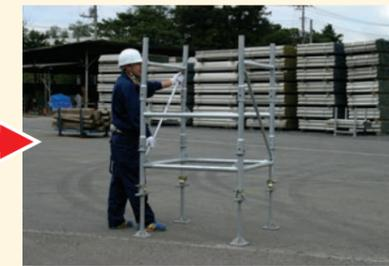
⑥ 計画段数になるまで④,⑤の作業を繰り返します。(各部材が完全に取付けられているか確認しながら作業)
