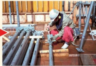
③ 12Kアルミサポートを計画図に従い建込みます。サポートスタンドを使用すると安定した作業ができます。
