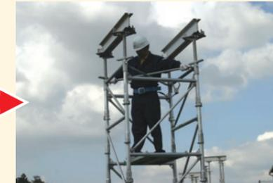
⑫ 完成です。所定の位置に設置後、再度レベル(水平、ジャッキ高)を調整します。
