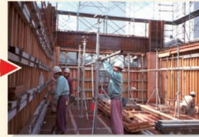
④ 単管つなぎと単管筋交いを専用クランプで取付けます。
