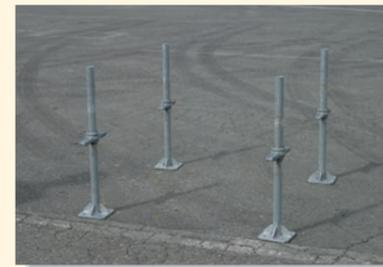
② ベースフレームを差し込みます。(ブレース取付部を上にして)
