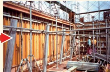
⑤ 大引材のストリンガービームを大引受けに取付けます。
