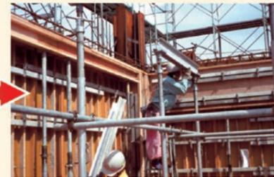
⑥ ストリンガービームと大引受けとTボルトで接合固定します。
