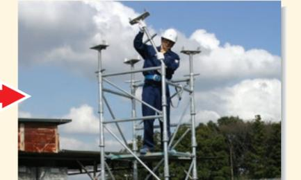
⑩ 大引材(ストリンガービーム)をTボルト・ナットにて取付け固定します。
