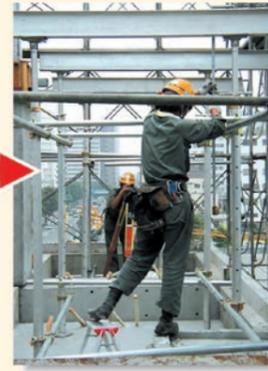
⑧ 計画図の通り各部材が配置されているか、構面が強固であるかを再確認します。
