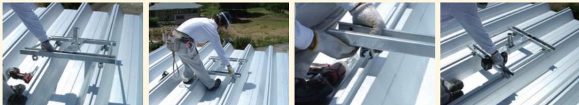
①支柱ベースを仮置きして下さい。その時にハゼ金具のナットをインパクトレンチで緩めておいて下さい。
