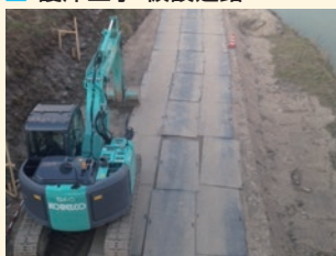
■ 護岸工事 仮設通路
