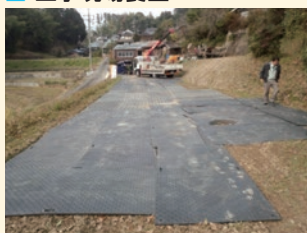
■ 工事現場養生
