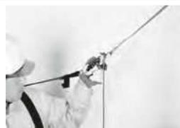
着脱式連結ベルトのO環に接続
