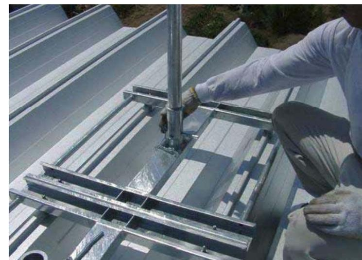
⑥支柱ベースソケット部と親綱支柱の穴にトグルピンで貫通させて固定する。
