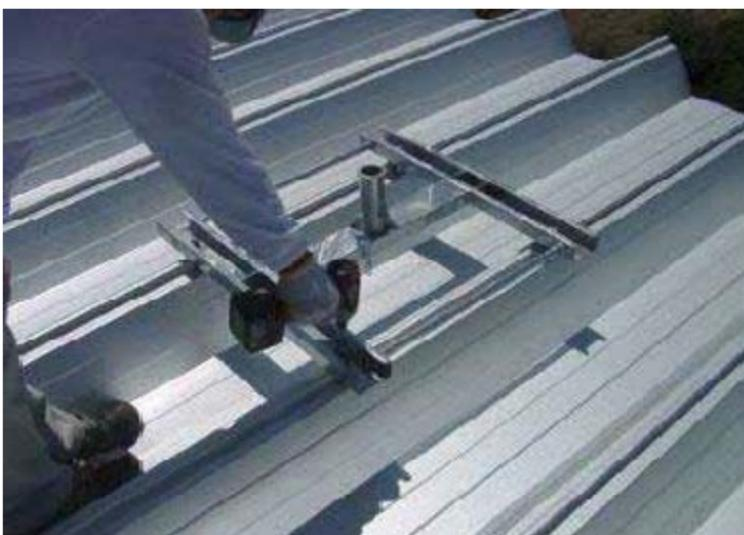
④ハゼ金具のナットをインパクトレンチで締め込み固定する。(ハゼ金具4ヶ所)
