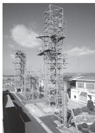
屋外試験鉄塔群
